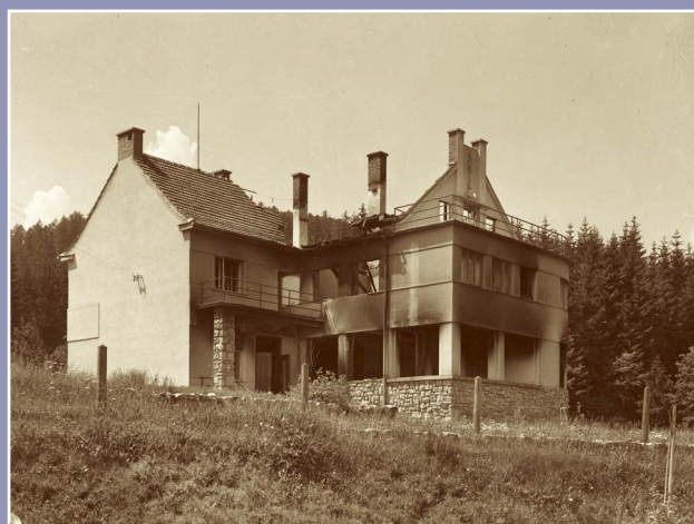
Vypálena byla i budova hotelu
