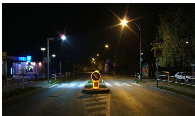
Obr. 24: Osvětlení přechodu pro chodce
