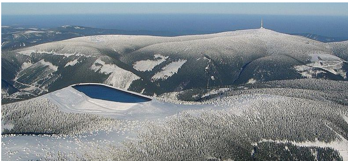
Obr. 50: Český unikát Přečerpávací elektrárna Dlouhé Stráně v zimě
